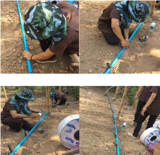
ภาพที่ 13 การติดตั้งวาล์วเทพน้ำหยด
