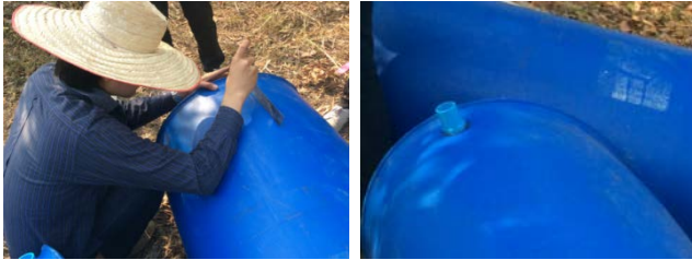
ภาพที่ 7 การประกอบถังเก็บน้ำและข้อต่อท่อจ่ายน้ำ
