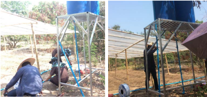
ภาพที่ 10 การติดตั้งท่อจ่ายน้ำเข้าสู่ระบบเทปน้ำหยด
