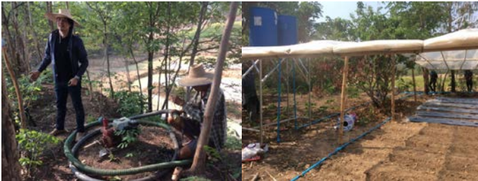
ภาพที่ 17 การติดตั้งระบบสูบน้ำและระบบจ่ายน้ำ
