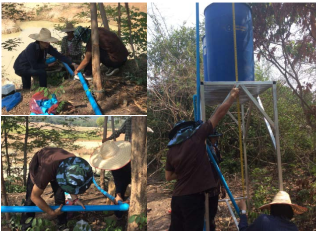
ภาพที่ 9 การติดตั้งระบบจ่ายน้ำเข้าถังเก็บน้ำ
