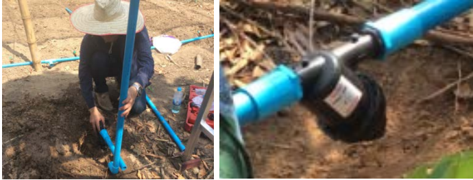
ภาพที่ 11 การติดตั้งกรองสิ่งสกปรก
